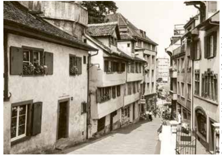
Foto: Peter Heman, Archiv Kantonale Denkmalpflege Basel-Stadt
